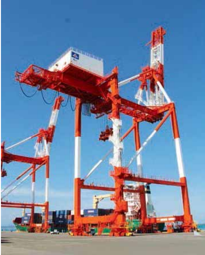
ガントリークレーン[Gantry Crane]
